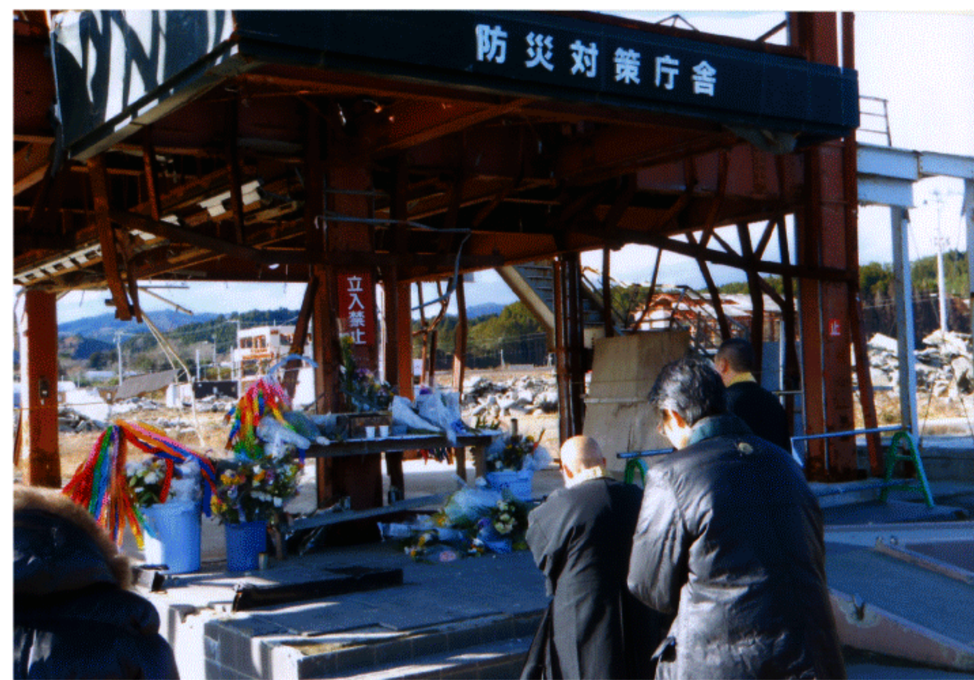
南三陸町 防災対策庁舎
