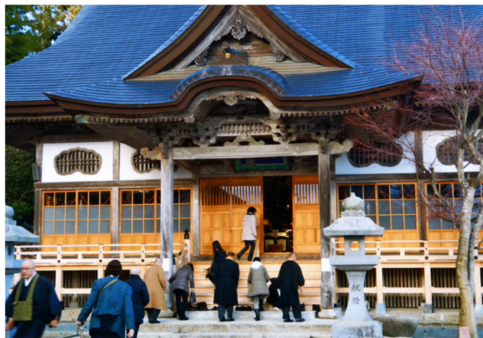
陸前高田 浄土寺様 高台にあった本堂は大規模半壊、庫裡は全壊で現在復旧中
